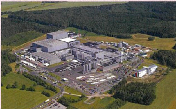
レップースドルフ工場全景
